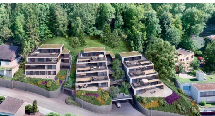
Visualisierung Terrassenhäuser Wettingen. Baubeginn: Frühling 2018.
