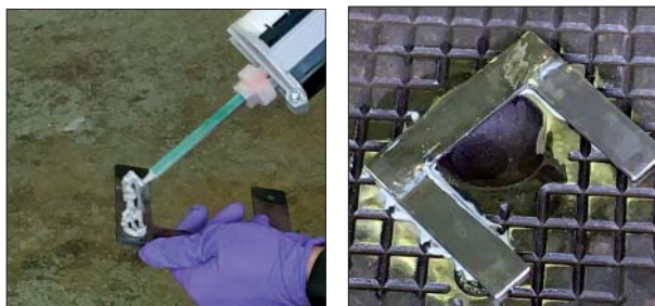
(links) Der Spezialklebstoff wird an die neue Halterung angebracht. (rechts) Die neue Halterung hält zuverlässig nach wenigen Minuten.
