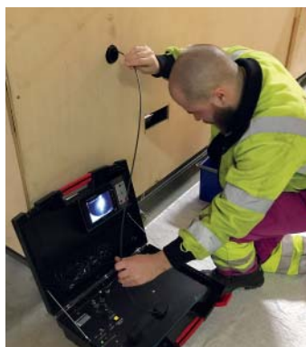
TV-Kontrolle eines Leitungssystems.
