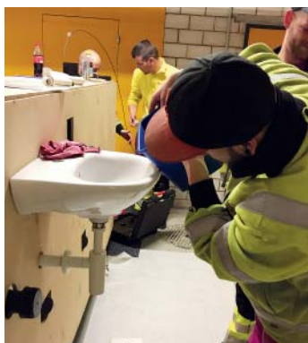
Füllprobe nach der Montage des Siphons.
