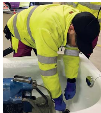
Eine Kunst: Bohren von Badewannenabläufen.
